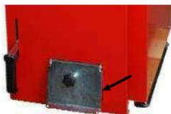
Die Luftklappe an der unteren Kesseltür (Asche-/Anheiztür) muss beim Betrieb mit dem Gebläse und der Steuerung immer geschlossen sein. Die Kette des Feuerzugsreglers muss von der Luftklappe getrennt sein und die Luftklappe muss vollen Kontakt mit dem Rand des Einlasskanals haben.
